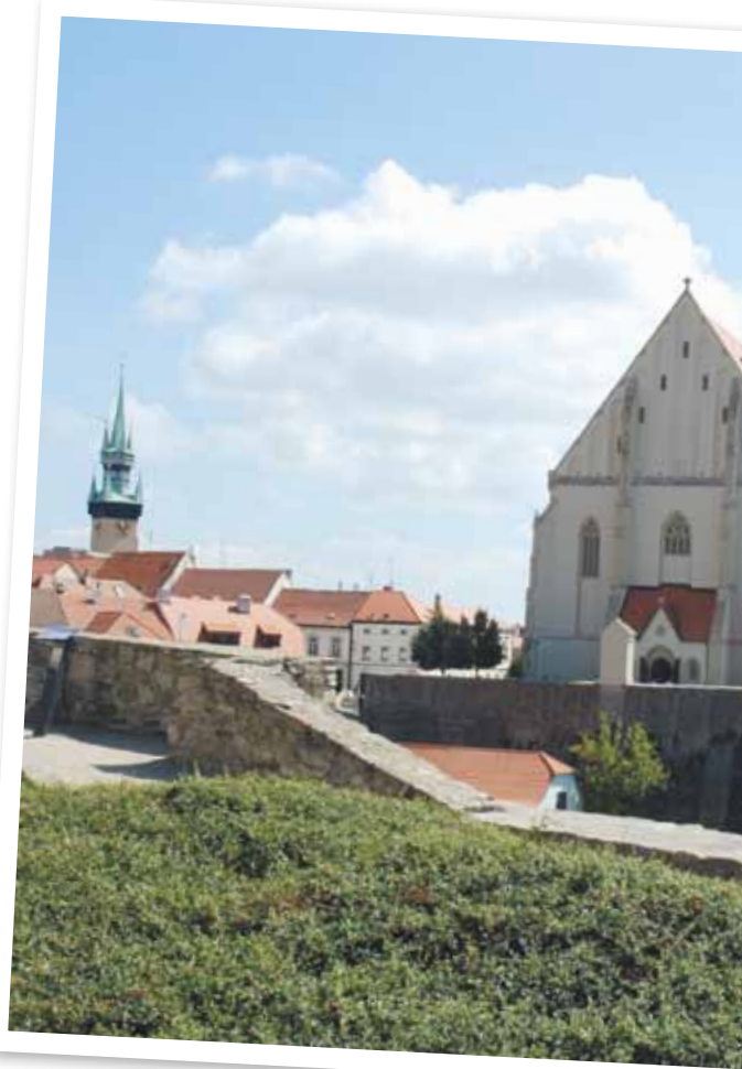
Kostel sv. Mikuláše a svatováclavská kaple (vpravo)
